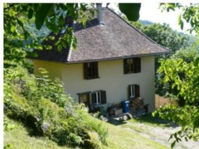
Toit de tuiles écailles, pente forte adoucie en bas de versant par un coyau. L'Eglise
