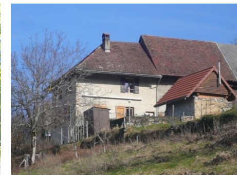
Ensemble maison, grange et four. Ici la maison a été construite dans le prolongement de la grange
