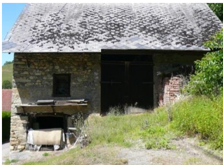
Accès à niveau, deux accès haut et bas
