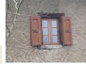
L'encadrement de la fenêtre est en bois, volets à cadre dauphinois.
