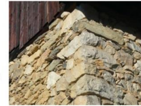
Pré Rondet, pierres d'angle plus importantes que celles du corps du mur
