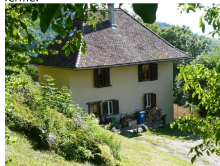
Toit à quatre pans, faitage court, coyau
