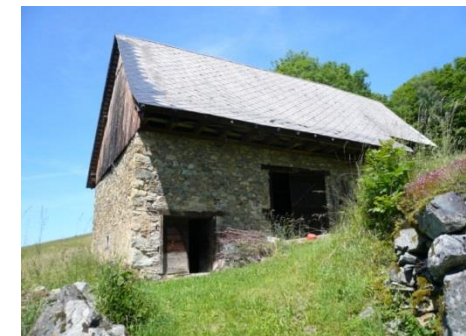
Murs en pierre locale ourdées au mortier de terre, linteaux et menuiseries en bois Ardoises losangées, coyau en bas de pente
