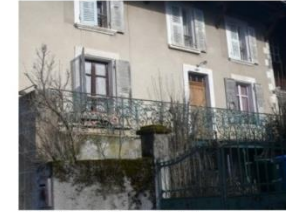
Enduit lisse et décor peint, balcon en ferronnerie, portail, un exemple de maison raffinée à Saint Jean le Vieux. Les menuiseries d'origine étaient peintes en clair (châssis) et en gris bleu (volets, ici des persiennes). L'Eglise
