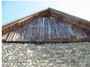
Bardage ventilé, l'Eglise
