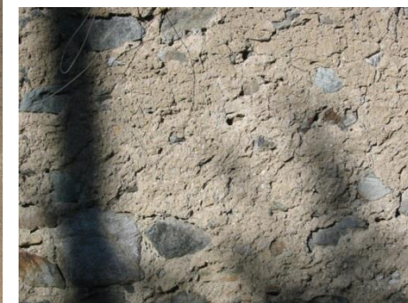
Détail d'un enduit ancien
