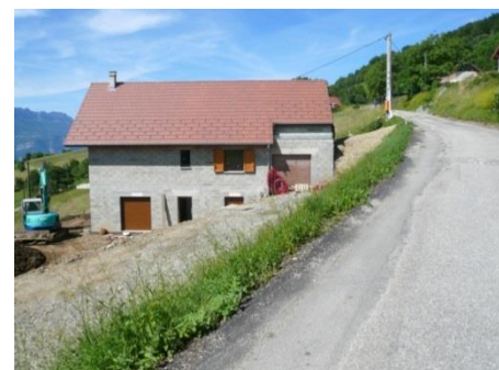
Implantation traditionnelle, en haut, en limite du chemin, chemin d'accès à niveau
