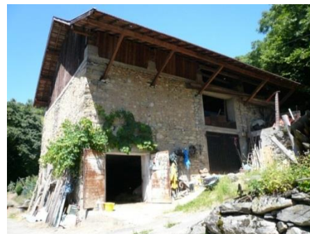
Avancées de toit sur consoles, en haut la structure bois est ventilée
