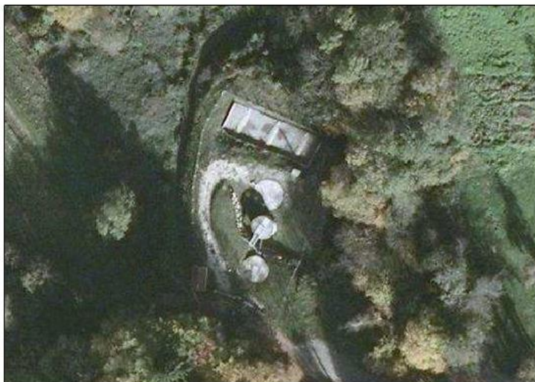
15- Photo aérienne de la station d'épuration de St Jean le Vieux
