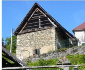
Ventilation du pignon, l'Eglise
