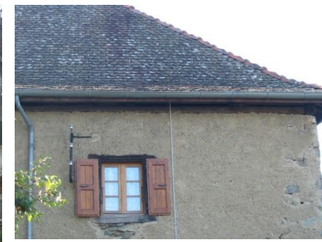
Tuiles écailles et coyau, l'encadrement de la fenêtre est en bois, les volets sont à cadre dauphinois.
