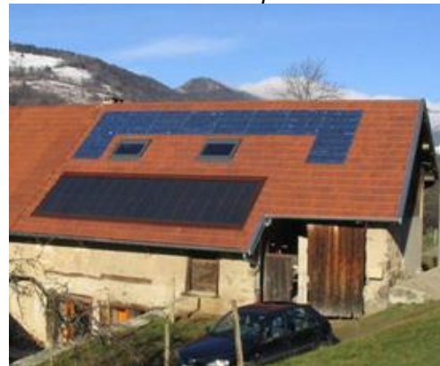
⊗ Pose interdite : Les accidents de toiture ne sont pas composés ensemble. Source internet
