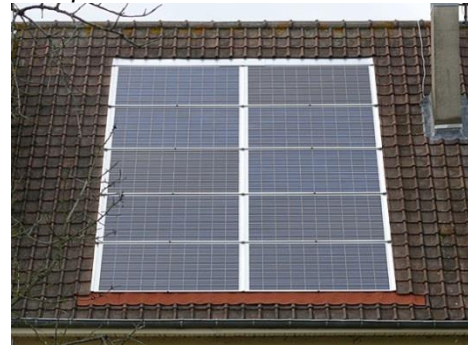
⊗ Interdit : les éléments de liaison ne sont pas de la même teinte que les panneaux. Source internet
