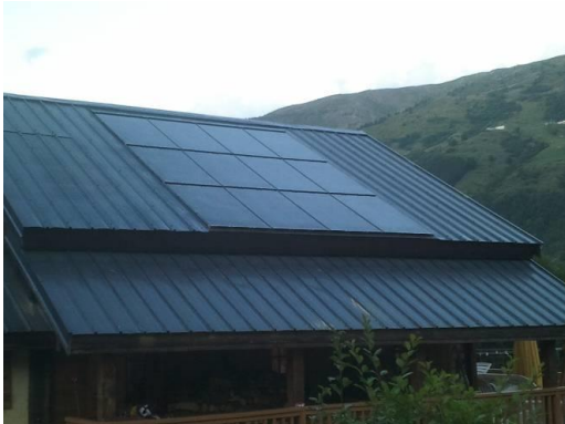
☺ Bonne intégration sur toiture en bac acier Valloire 73, photo internet Activolt.
