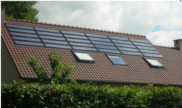
⊗ Pose interdite : Les accidents de toiture ne sont pas composés ensemble. Source internet
