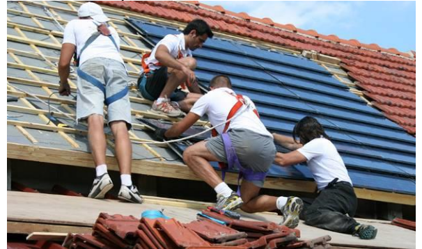
☺ Intégration de panneaux solaires sur une toiture en tuiles mécaniques. Photo internet SM
